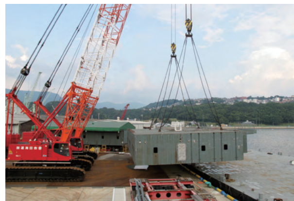
クレーン作業風景
