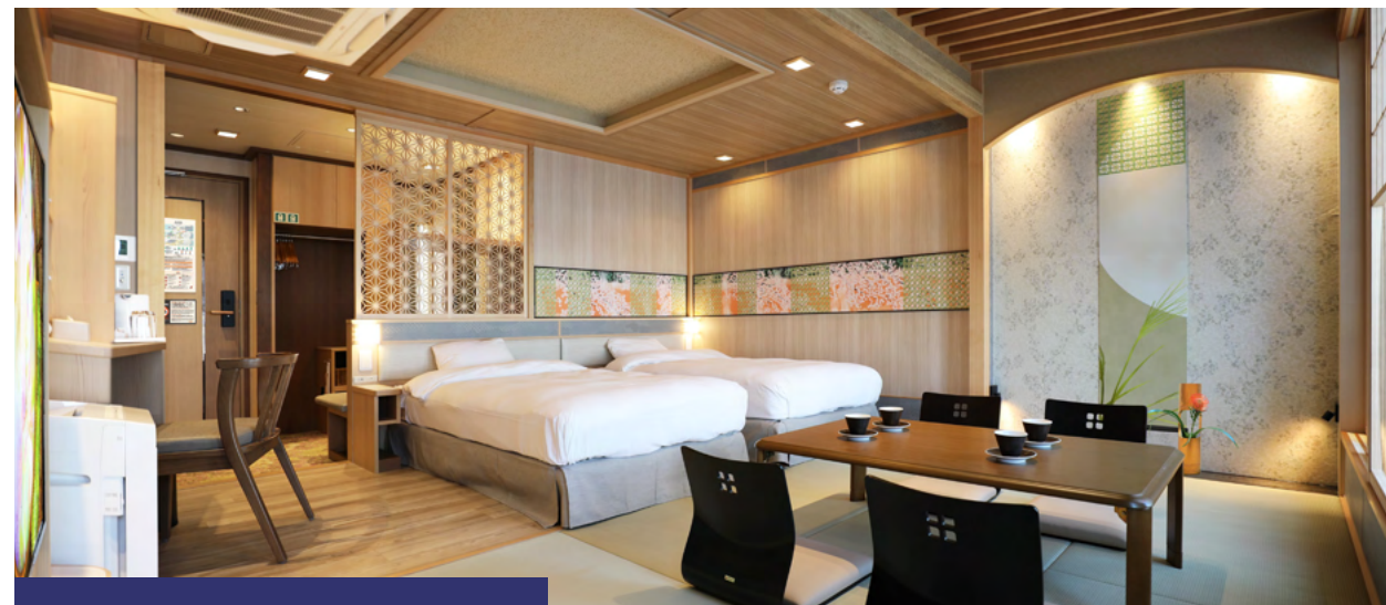
客室内装工事(設計・施工)
