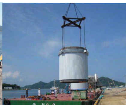
搬出・出荷作業風景
